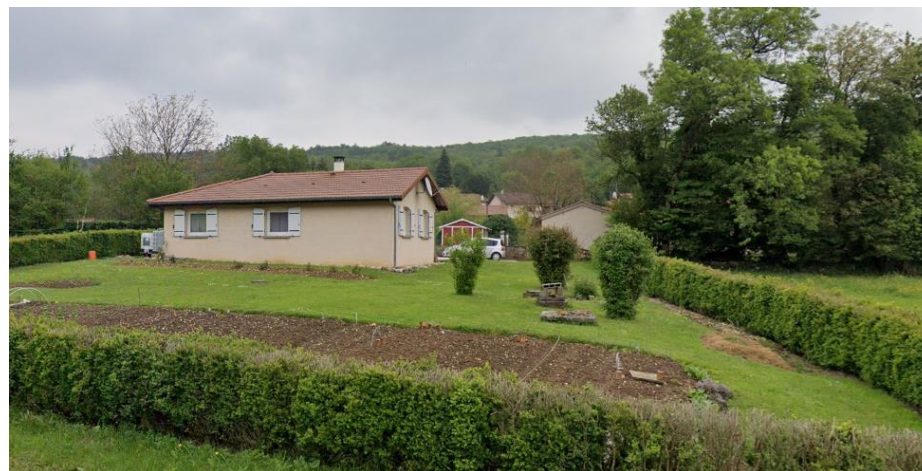
Exemple d'habitat pavillonnaire de Montmerle
