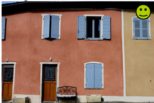
Exemple d'une façade à enduit gratté de couleur ocre/rouge et ocre/brun
